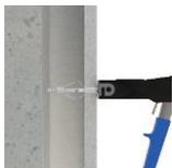
Colocar la cabeza del tornillo en la pistola de instalación. Accionar la misma hasta que se produzca la expansión total del anclaje, cuidando de no extraerlo.
